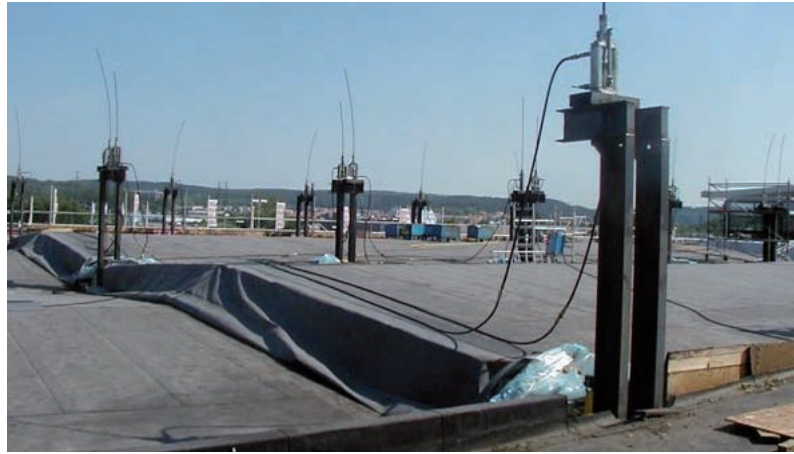
Wireløftere klar til løft af komplet tag.
